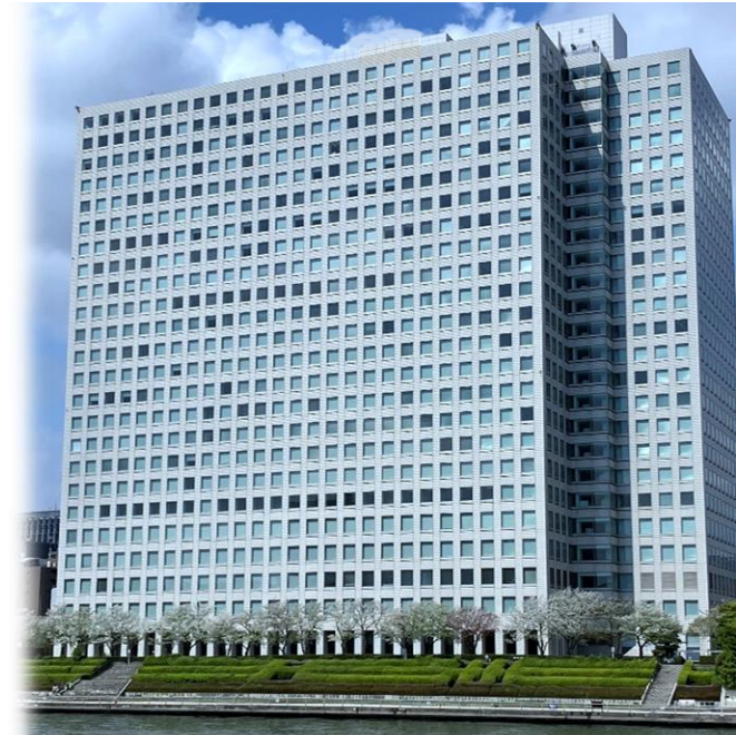
MSH日本橋箱崎ビル
